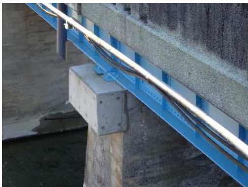
図 8. コンクリート補修
