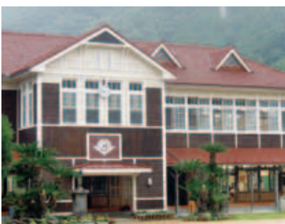
エコ改修なった翠小学校
