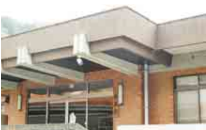
土砂災害時に、避難場所として利用できない施設の一つである「緑風館」
