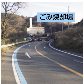
国道378号整備(三秋地区)
