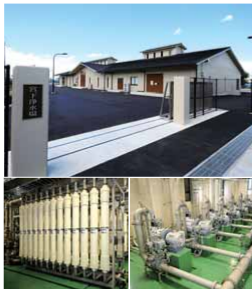
宮下浄水場(平成24年7月完成) 事業費16億4,900万円
