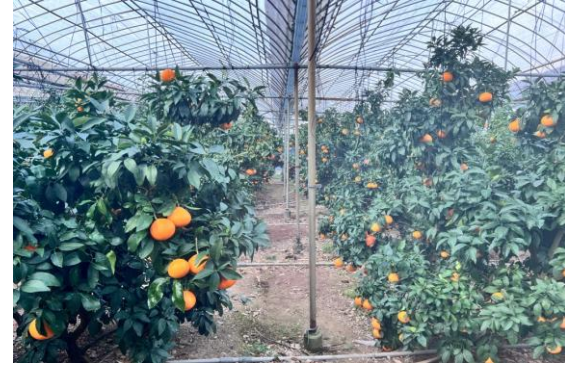
老朽化している農業用施設
