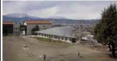
写真1 山並みに呼応する建屋観
