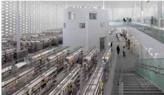
読書室の吹き抜けから2階の読書室を見える。部屋の30mm、高さ30mmの網目パネルで高さ12mの吹き抜け空間を支える
