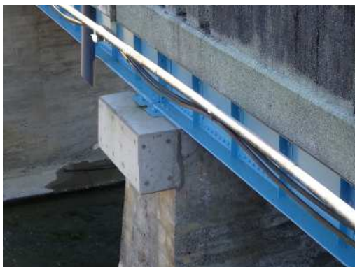
図 8. コンクリート補修
