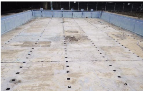
漏水の修繕と塗装の改修をする五色浜公園の25mプール
