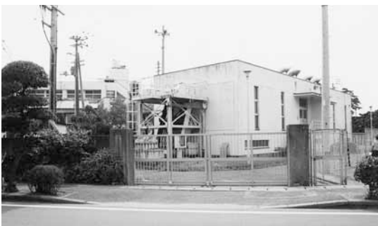
安広ポンプ場
