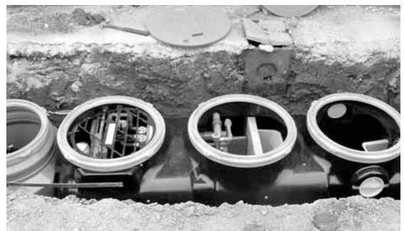
浄化槽の設置
