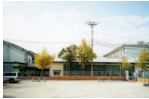
港南中学校の給食室
