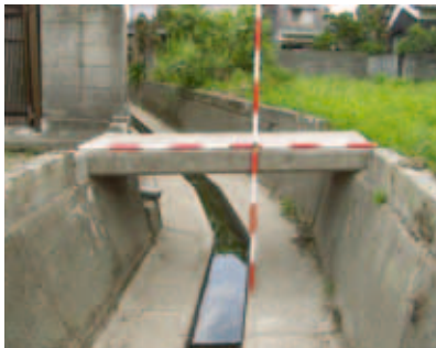
複水路化とかさ上げ工事
