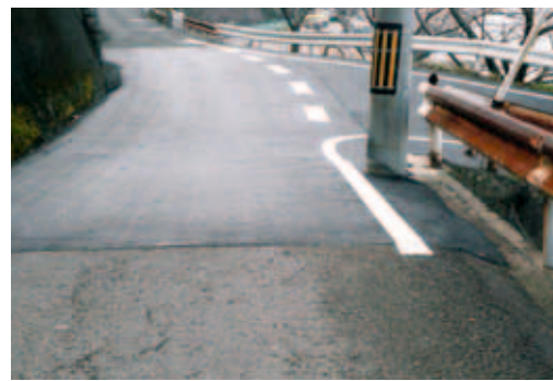
補修された市道
