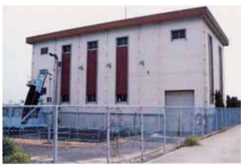
大谷ポンプ場
