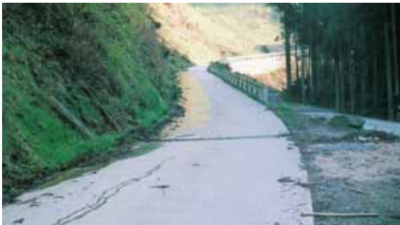
登記がされていない林道
