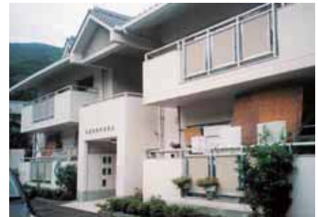
公営住宅門前団地
