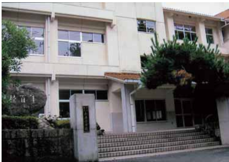
活用が検討されている永木小学校校舎
