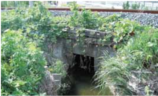
軌道敷内の暗渠（高瀬）
