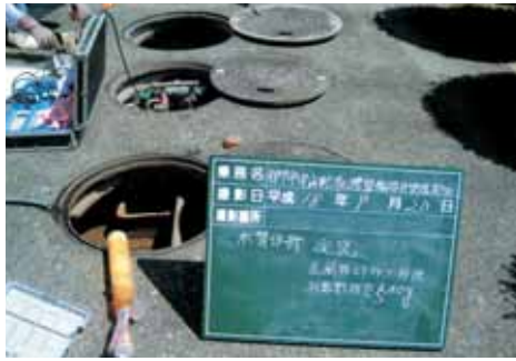
浄化槽点検中
