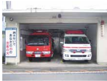
双海消防庁舎
