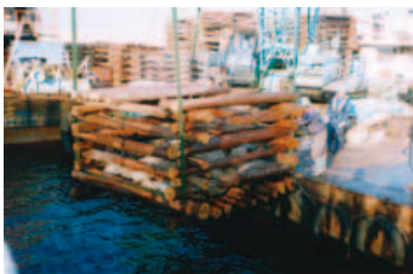
間伐材を利用した魚礁の設置風景
