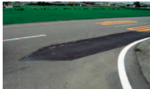
市道稲荷下三谷線の道路補修箇所
