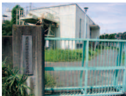
安広ポンプ場
