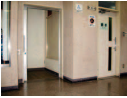
市民会館の身体障害者用トイレ
