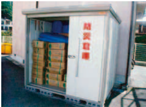
防災倉庫(伊予消防署中山出張所)
