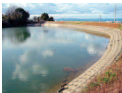
改修された稲荷八幡池
