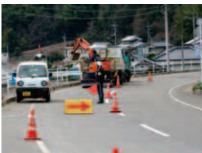
唐川地区農業集落排水施設工事現場
