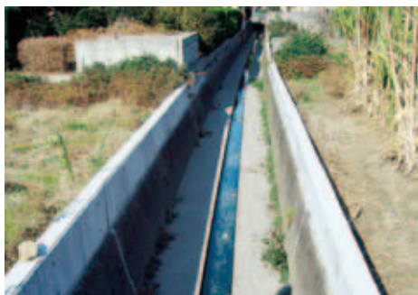
越水後かさ上げされた水路
