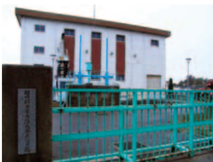
大谷ポンプ場
