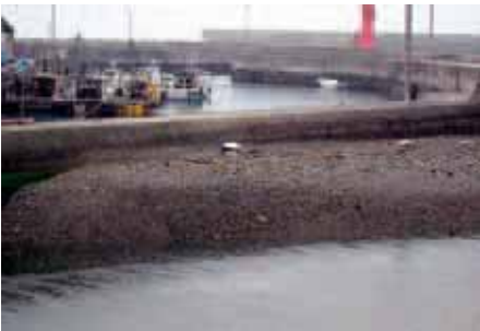
土砂が堆積した上灘川河口
