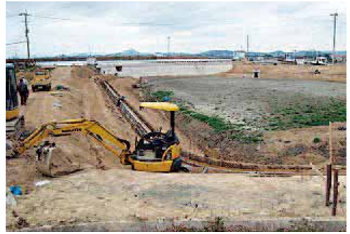
土地改良事業で改修中のため池
