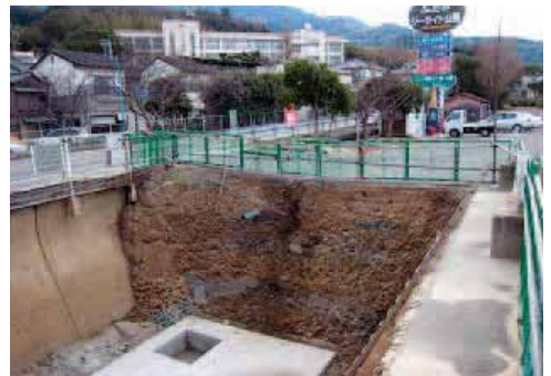
シーサイド公園内の防火水槽設置工事
