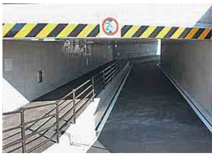
郡中小学校前の地下道
