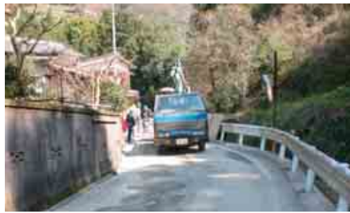
唐川地区農業集落排水事業の建設現場
