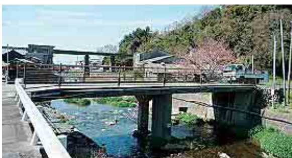
樋の本八景山線1号橋（双海地区）
