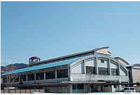
港南中学校体育館
