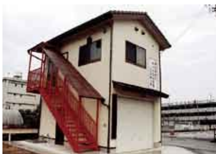
今年度完成した下吾川消防団詰所
