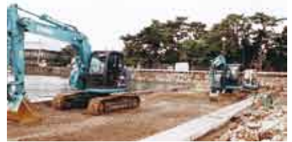
伊予港の工事現場
