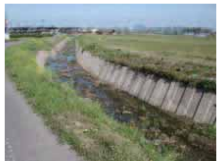
堆積土砂の除去を行った長尾谷川
