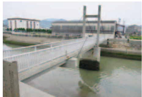
改修工事を行う観月橋（新川）
