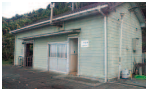
トイレを改修予定のJ R 下灘駅
