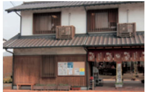
町家の国道側に面した外壁
