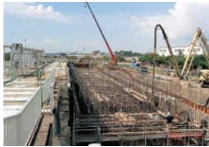
増設中の下水浄化センター
