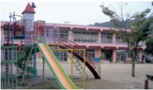
耐震補強が必要な上灘保育所
