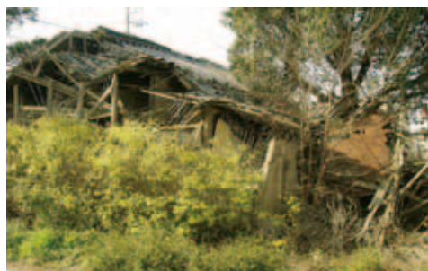
倒壊した家屋
