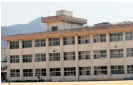
郡中小学校屋上に設置されている水槽
