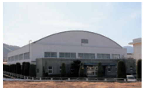
耐震補強予定の北山崎小体育館
