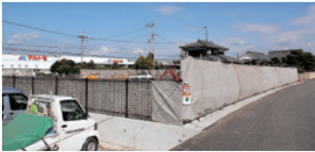
施設の建設現場 (本郡)
