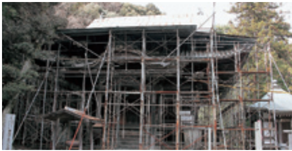
宝珠寺（ほうしゅうじ）の屋根改修
