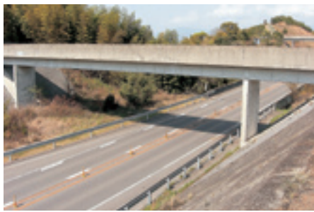
跨高速道路橋
