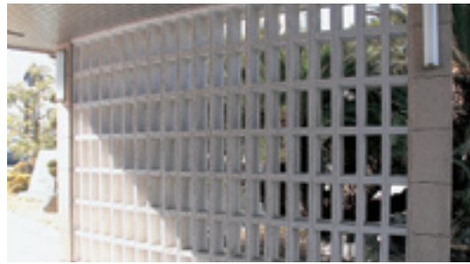
水洗いした市役所玄関前
